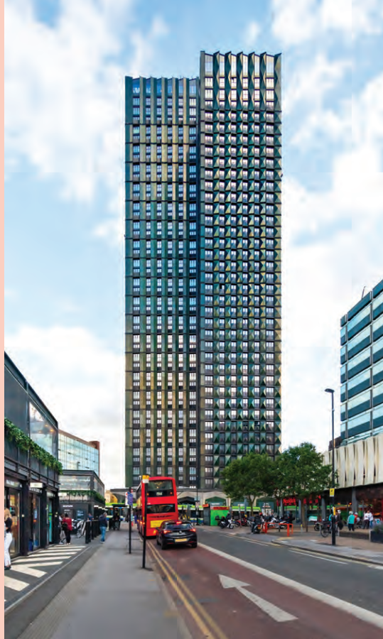
Édifices sur George Street à Croydon, Angleterre, TIDE Construction Limited et MJH Structural Engineers.
