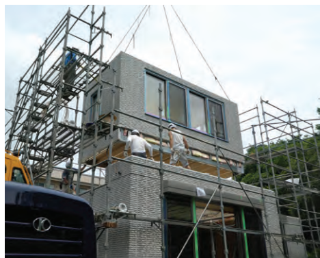
Installation de modules Misawa Hybrid (Japon).
