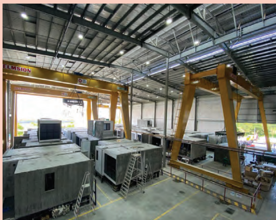
Avenue South Residence , Singapour, modules produits par United Tec Construction.
