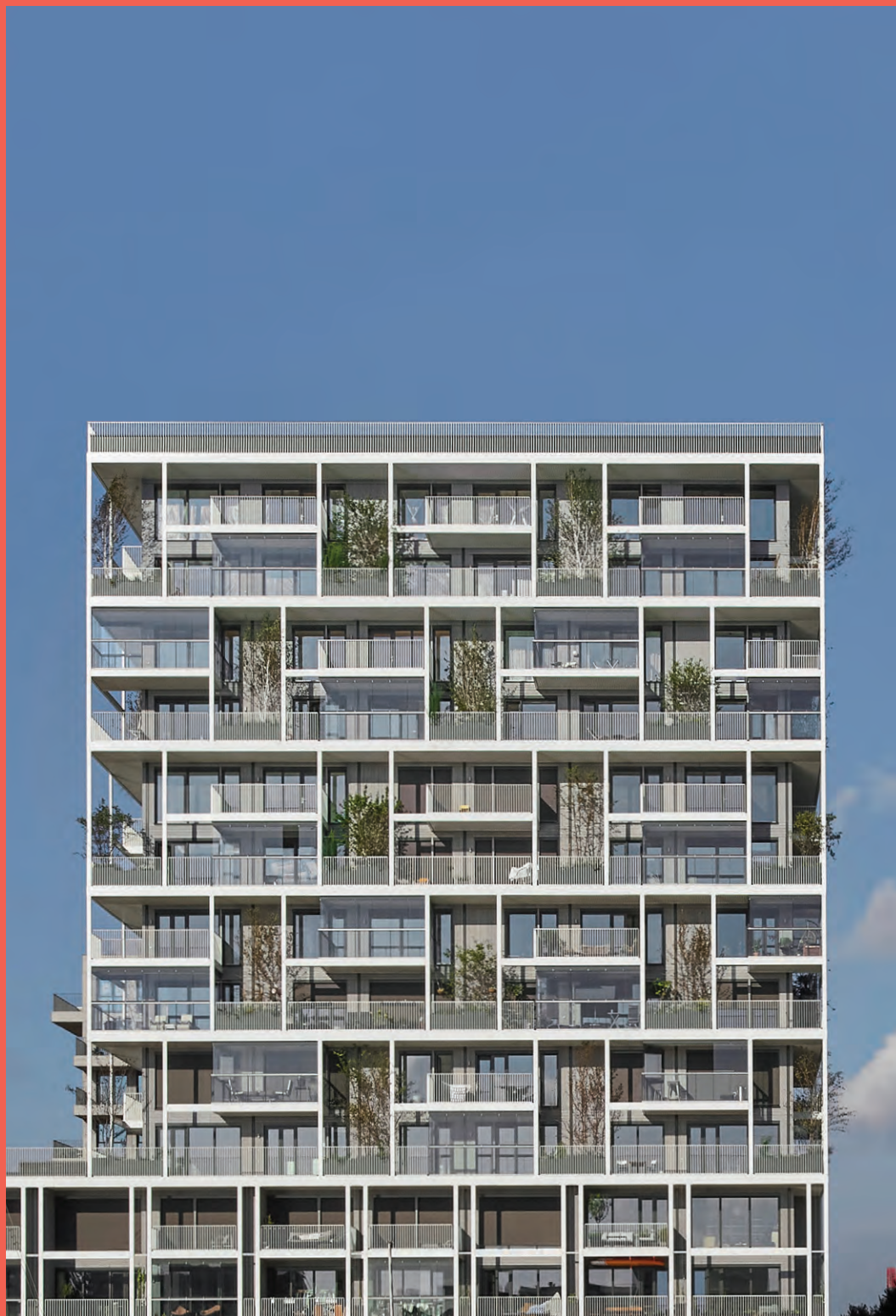
En page de gauche, structure d'accueil et adaptabilité des logements de l'édifice BSH20A 'Stories' à Amsterdam, Olaf Gipser Architects.
